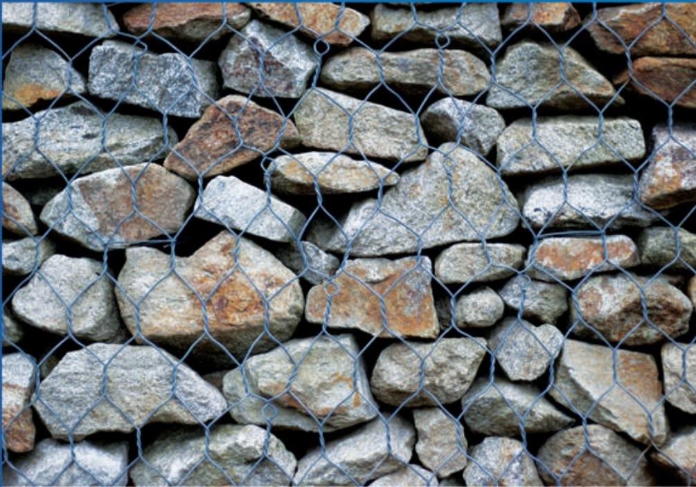
Caja fabricados con malla hexagonal de alambre de acero el cual se rellena con piedra para sistemas de protección.
